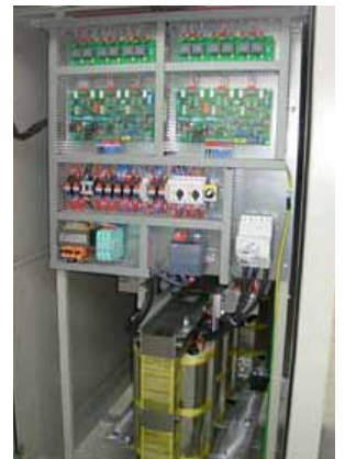
INVERSIONE STATICA DELLA POLARITÀ Static reversing polarity
